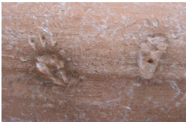
Eichhörnchenspuren auf Dachziegeln in der Römervilla (Bad Neuenahr), die vor dem Brennen im Ton hinterlassen wurden.
